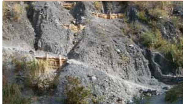
Sistemas de control de cárcavas en una cuenca en Bolivia mediante el uso de diversas técnicas de GST. Foto: George Heim.
