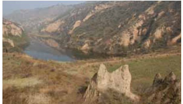
Una presa en la meseta de Loess, en China, almacena los sedimentos hasta que se llena. Esta provisión se utilizará más tarde para el cultivo. Foto: Hanspeter Liniger
